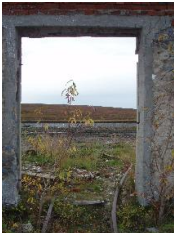
Zakład wapienniczy Известковый завод Fot. 42. Szyny wąskotorówki wychodzące z centralnej części budynku Узкоколейные рельсы, проходящие через центральный проем здания Fot. 43. Piec – widok od strony północnej. Печь вид сзади (с севера)
