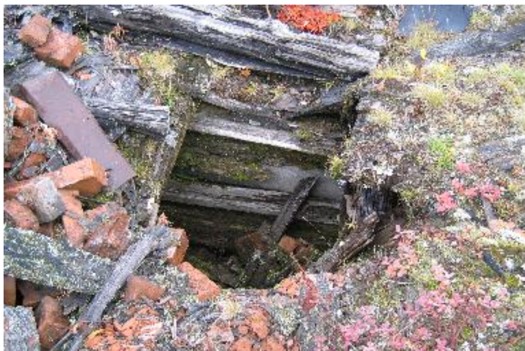
Fot. 94. Drewniany fundament piekarni Деревянный фундамент пекарни
