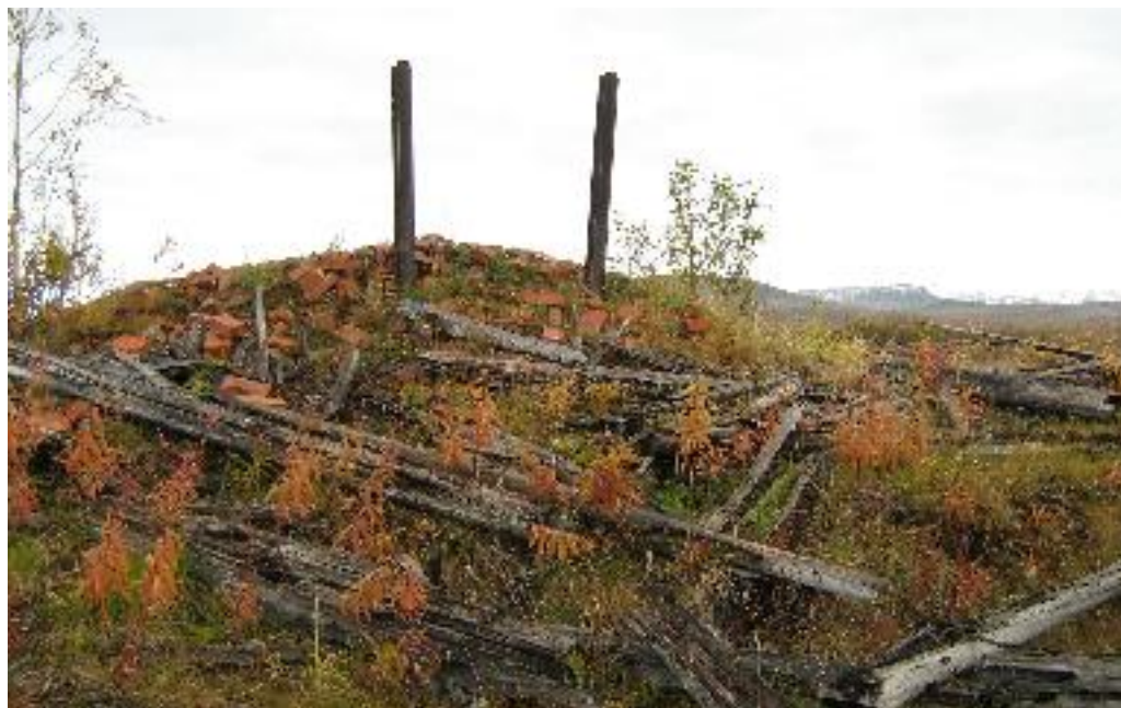
Fot. 93. Dawna piekarnia – ruiny budynku Бывшая пекарня – развалины строения
