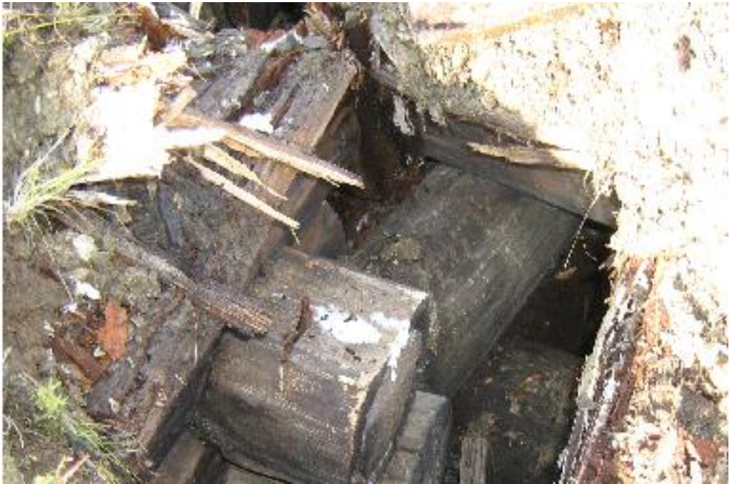
Fot. 115. Drewniane fundamenty. Деревянные фундаменты
