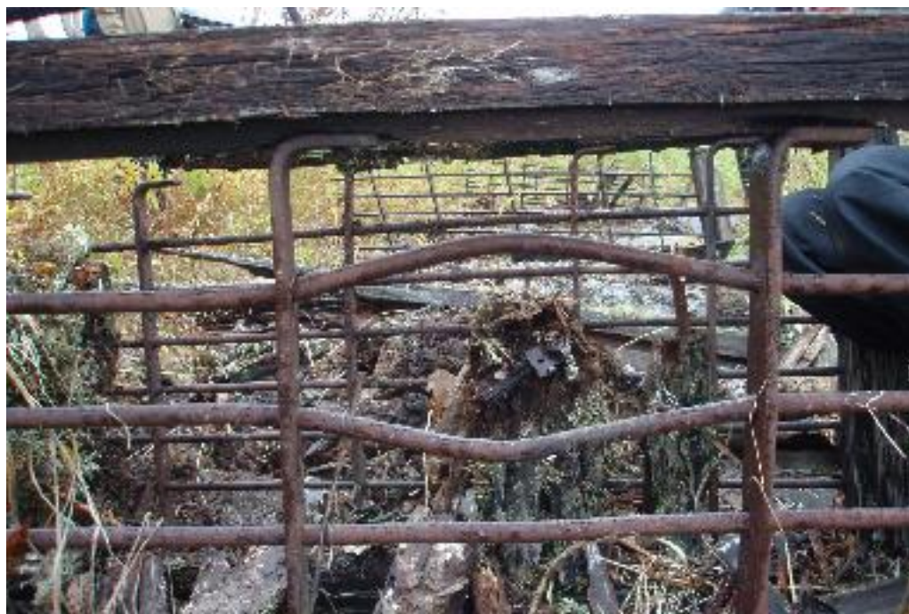
Fot. 69. Rozgięte pręty kraty okiennej
