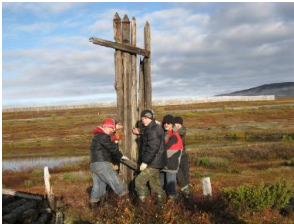
Fot. 100. Część ogrodzenia z pali po podniesieniu – widoczna jego wysokość
