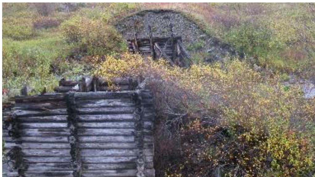
Fot. 53. Zniszczony most Разрушенный мост
